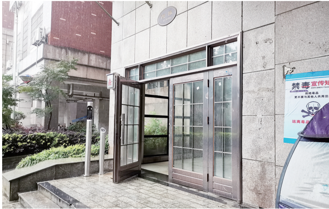
▲楼栋大堂大门已经被更换,业主称之前的大门才使用两年 记者 姚时美 摄
