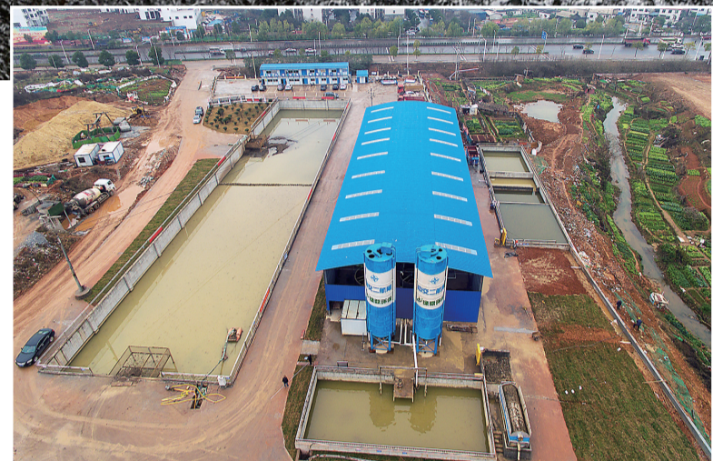
航拍淤泥脱水厂。
