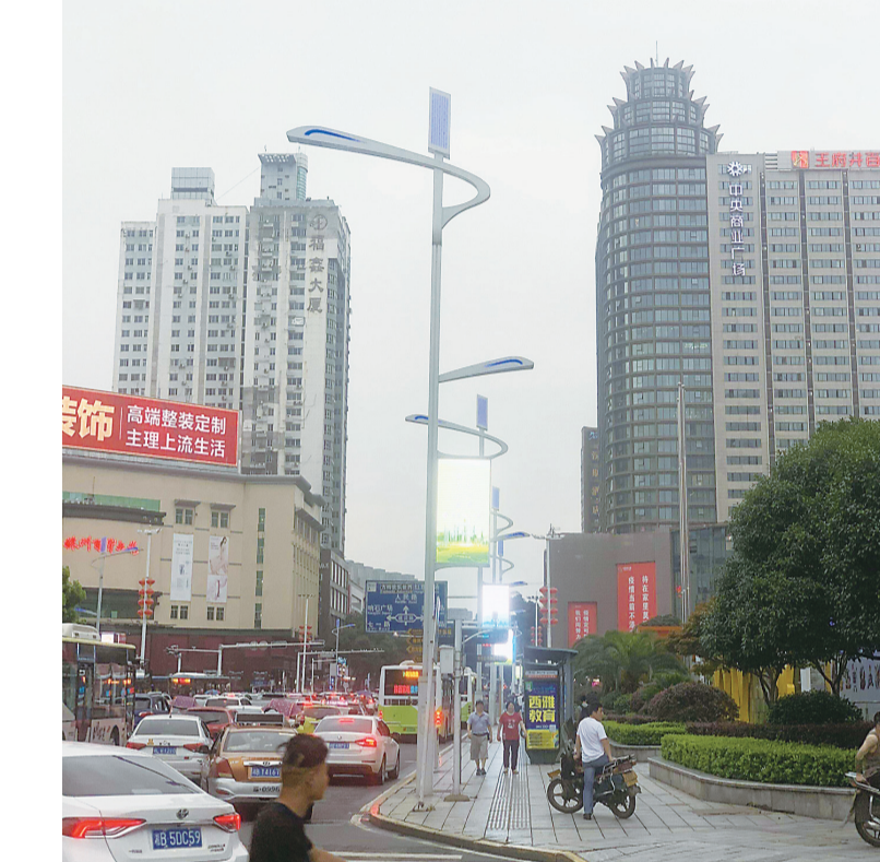
▲中心广场沿线的智慧路灯 记者 伍婧雯 摄
