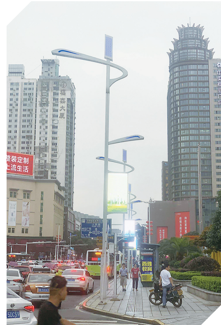
▲中心广场的智慧路灯,能提供WiFi、给手机充电。这种路灯将成为我市5G网络建设的重要载体之一 记者 伍靖雯 摄
