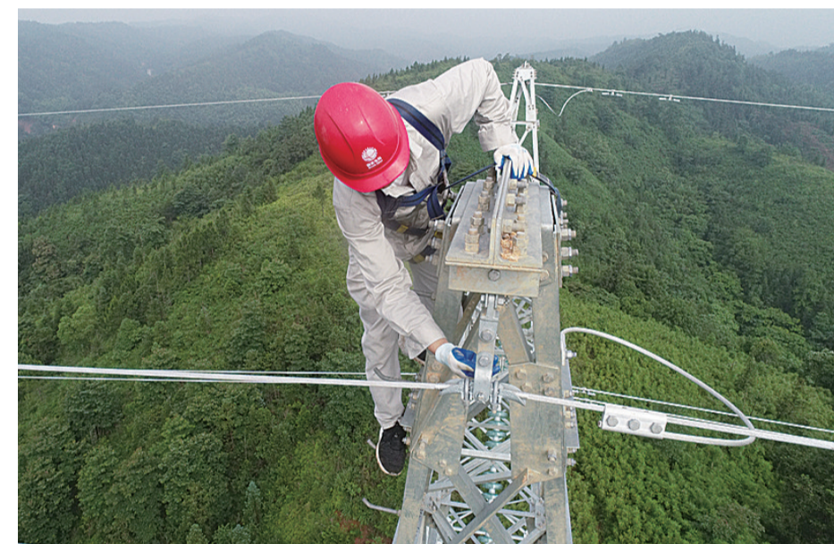
▲供电公司员工对输电线路实施维护 通讯员供图
