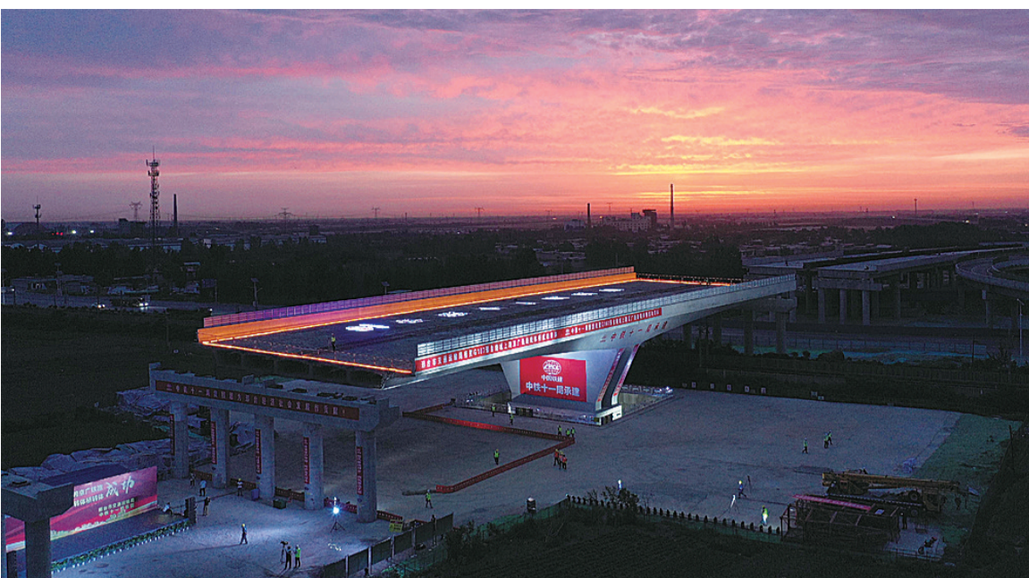
◀G107河北邢台段绕城上跨京广铁路转体桥实现成功转体(6月16日无人机照片)
