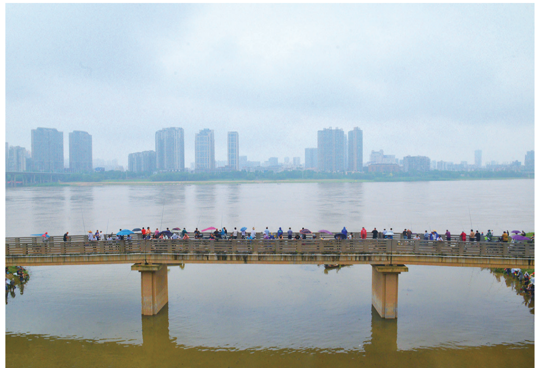
▲近日,受持续强降雨影响,湘江水位持续上涨 记者 谢慧 摄
