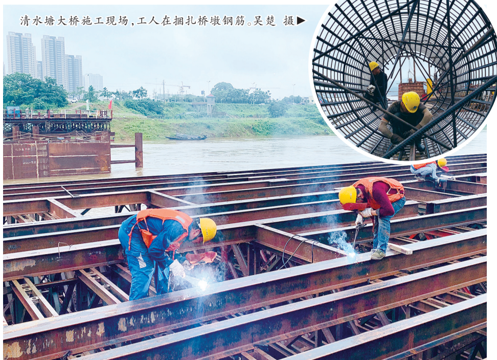
▲清水塘大桥施工现场,焊工临水而立进行钢围堰顶平台施工。吴楚 摄
