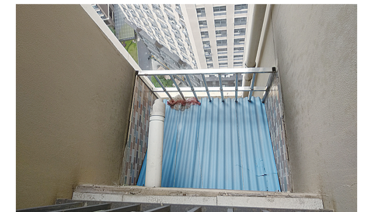
▲楼下业主搭建的雨棚 见习记者 黄欣雨 摄
