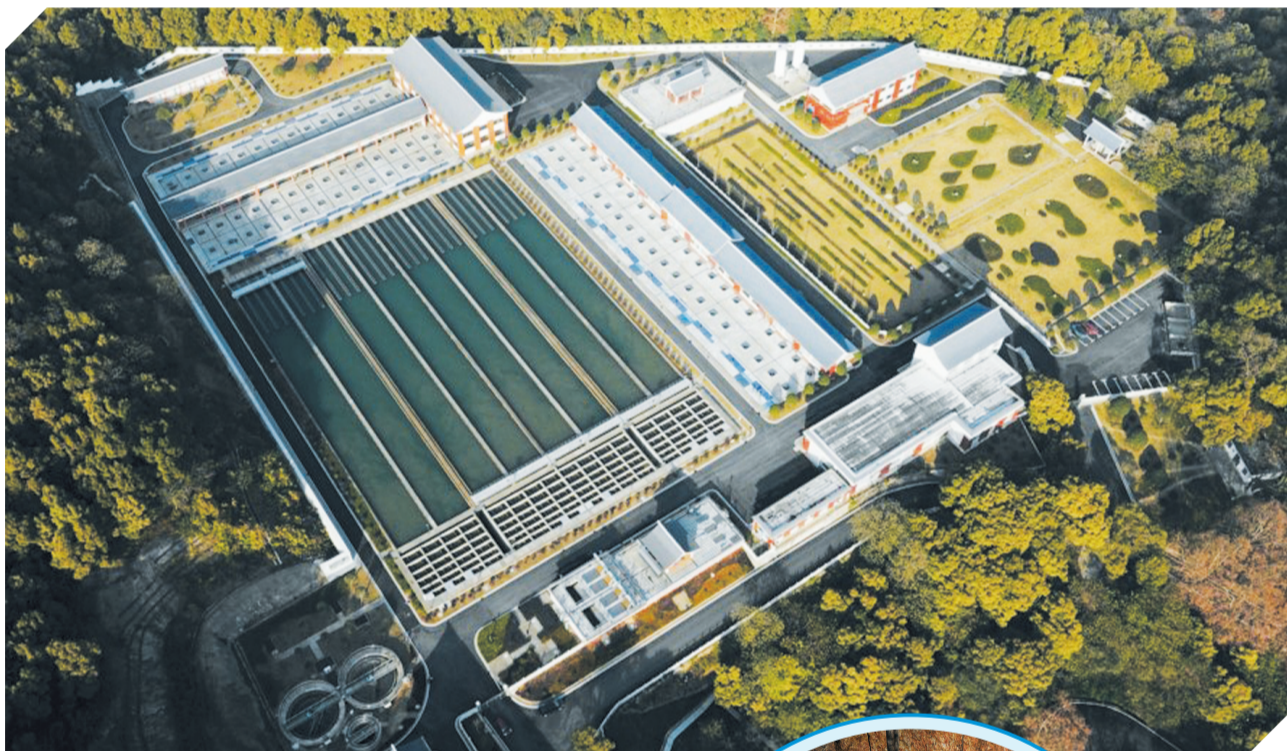
▲二水厂俯视图。
