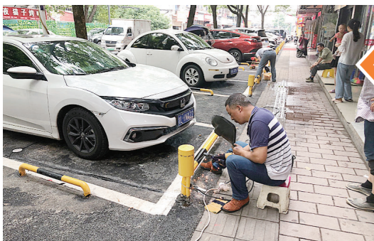
工人们正在紧锣密鼓地安装停车设备。任远 摄
