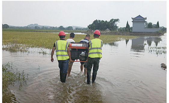
▲道路受阻,攸县移动维护人员扛起100余公斤的油机徒步前往基站
