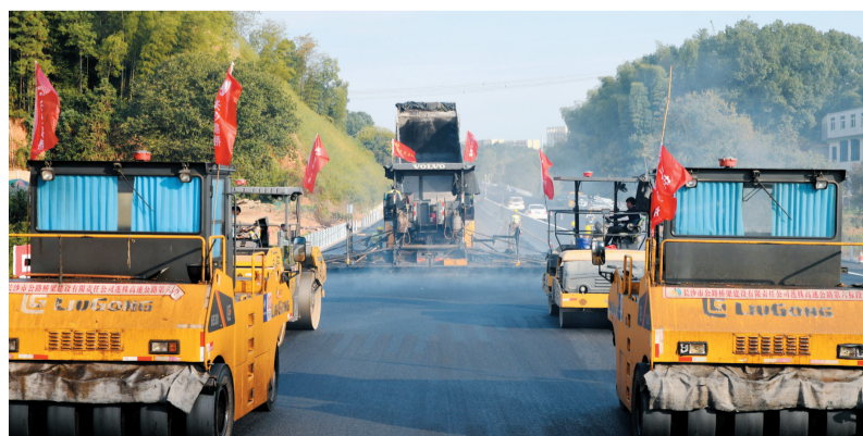
▲沥青路面摊铺
