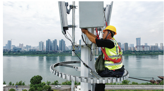
▲5G建设如火如荼,株洲移动工作人员正在贺家土沿江美化塔上安装5G天线
