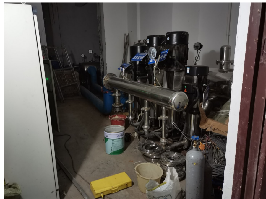
▲菜茵小镇正在修建水箱,增加水泵 记者 姚时美 摄
