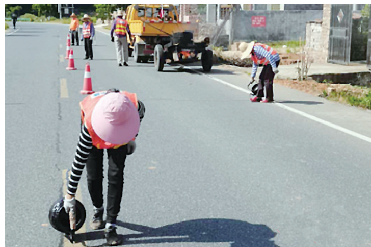
养护站工人开展清灌缝养护作业。
