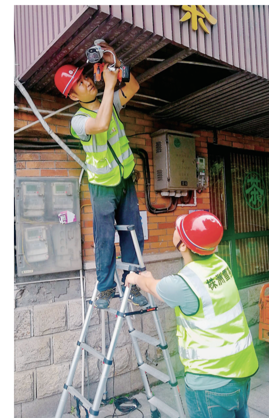
▲昨日下午,施工人员为聚贤茶楼安装摄像头 记者 李卉 摄
