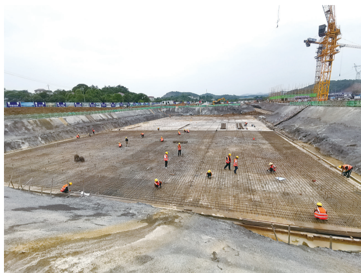
建宁港金山污水处理厂现场施工正酣
