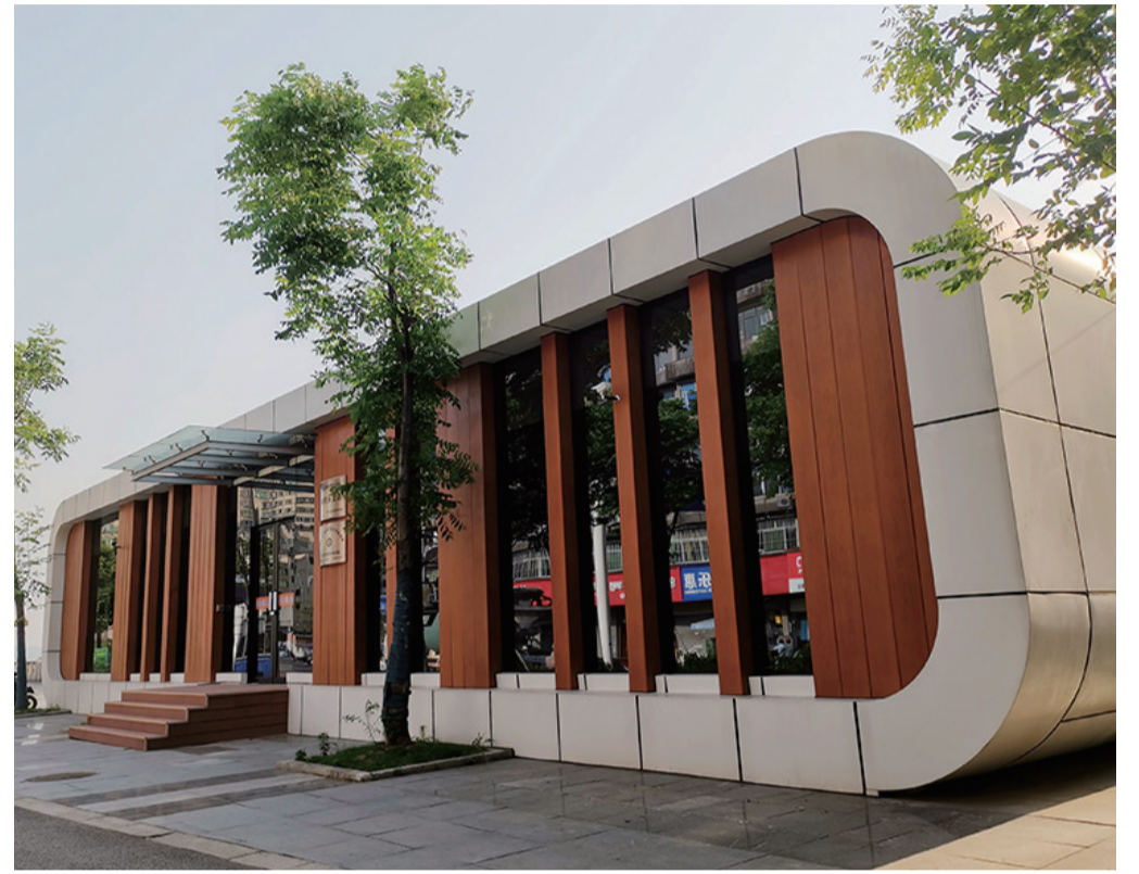
▲株洲水文站工作用房已经建成 记者 戴凇 摄
