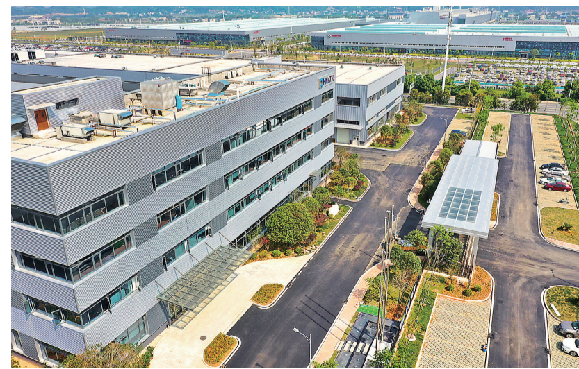
株洲新能源机动车检测中心项目建设现场。唐剑华 摄
