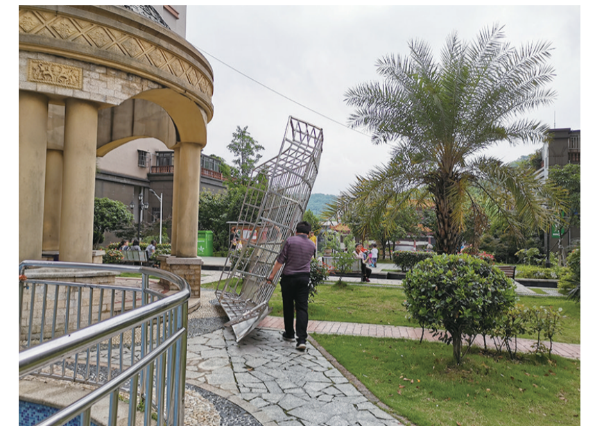
▲前日,掉落的防盗窗被抬走 记者 姚时美 摄
