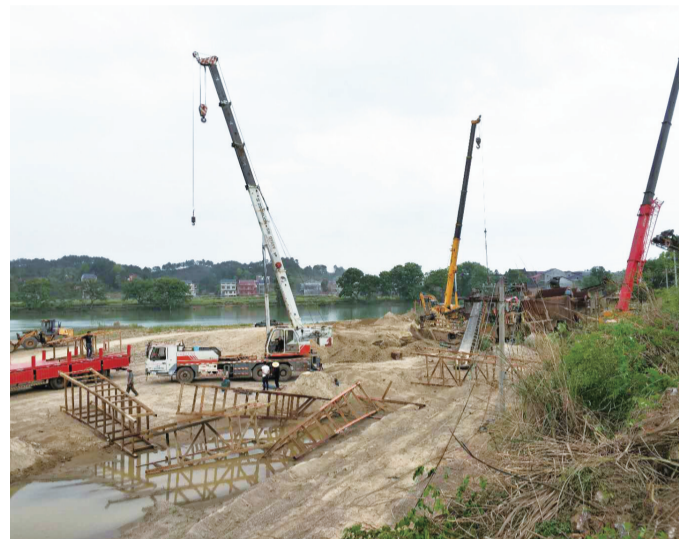
鸿运砂场整治现场。通讯员/供图
