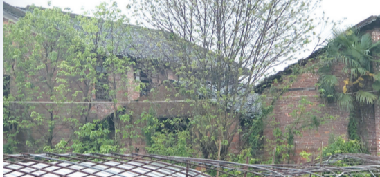
東門集材厂现状
