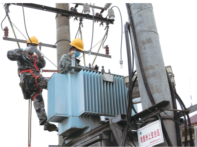
电力部门改造电网。王军 程钺 供图
