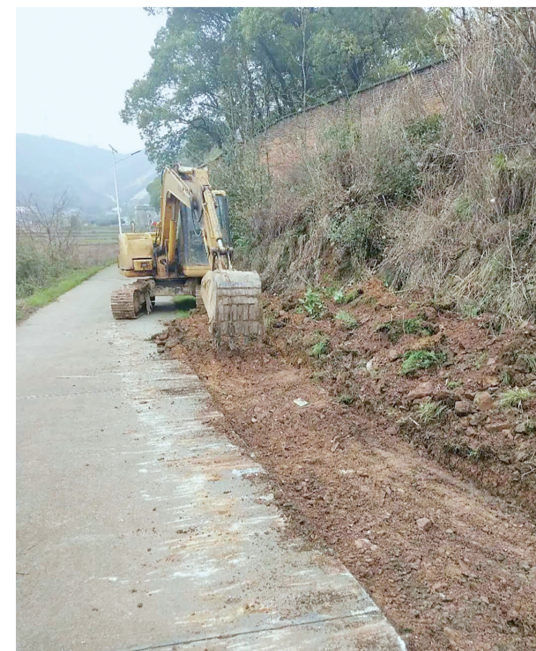
▲长石村村道拓宽工程现场 通讯员供图
