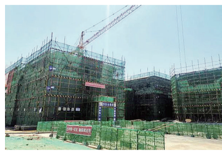
爱心大院项目施工现场
