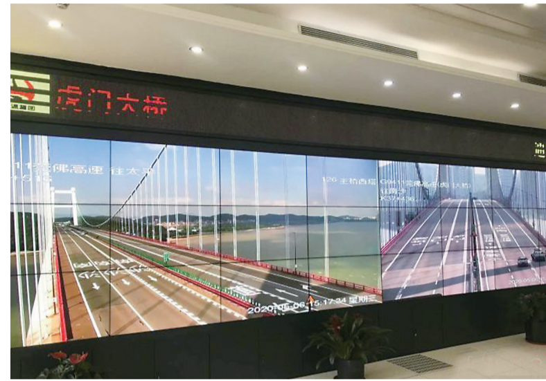
▲虎门大桥管理中心对桥梁进行实时监测
