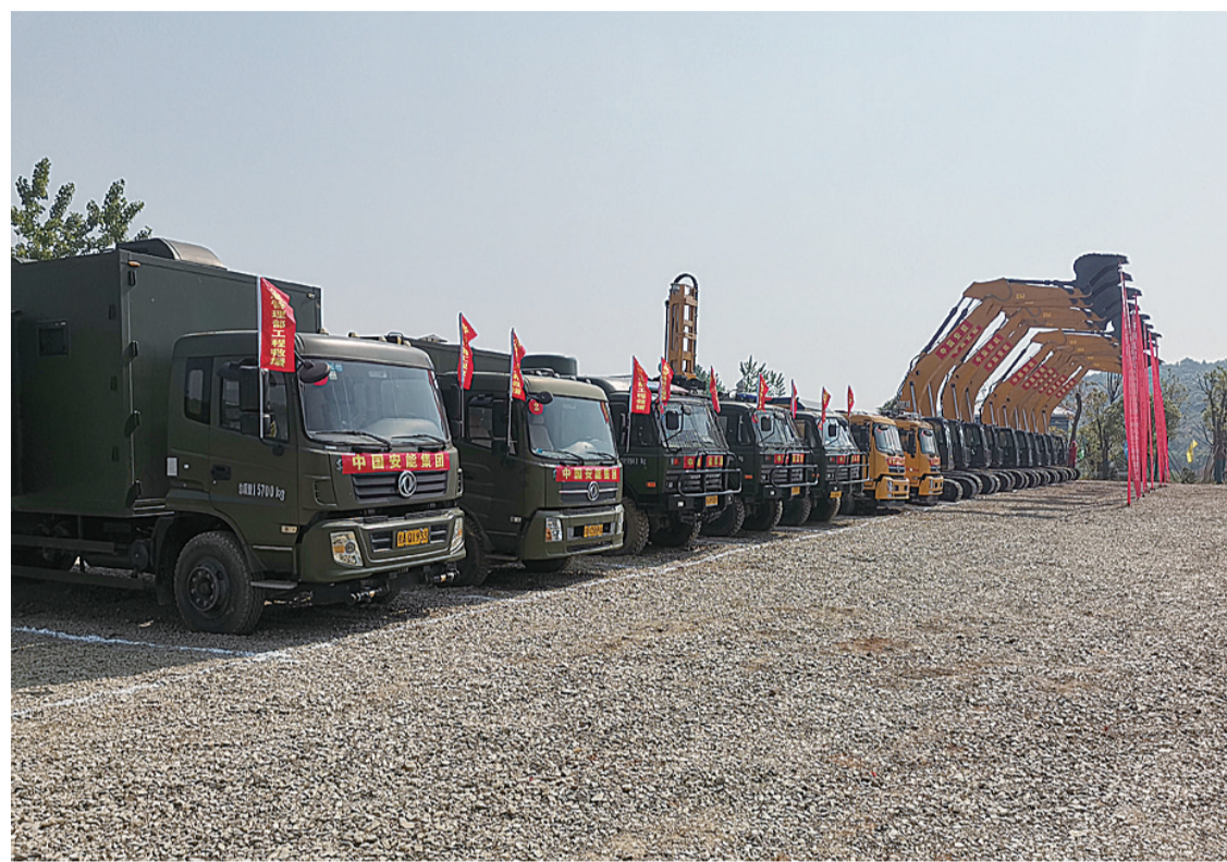
▲中心城区污水系统综合治理一期工程开工现场 通讯员供图
