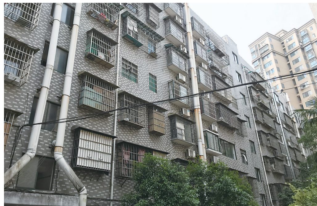
▲顺鑫佳园小区外墙油烟管林立 见习记者 黄欣雨 摄
