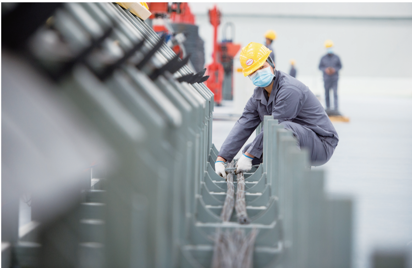
湖南国信OC装配式建筑生产基地生产线上忙碌的人们。
