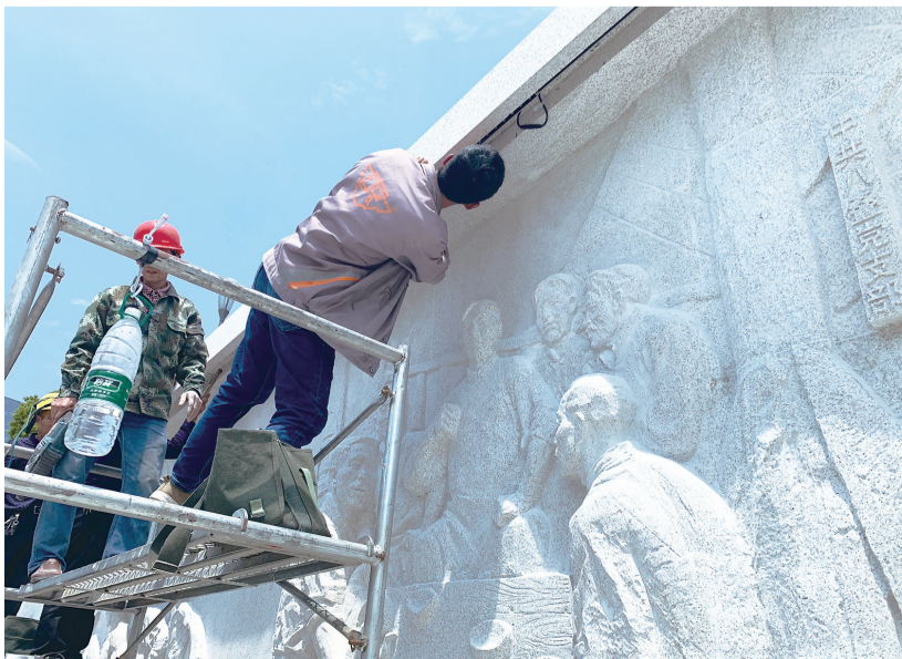
文化艺术墙施工现场,工人正在安装照明灯管。 吴楚 摄
