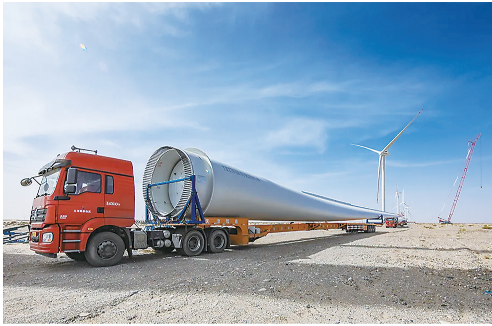
▲中车株洲所3.xMWD160风电机组吊装成功 受访企业供图
