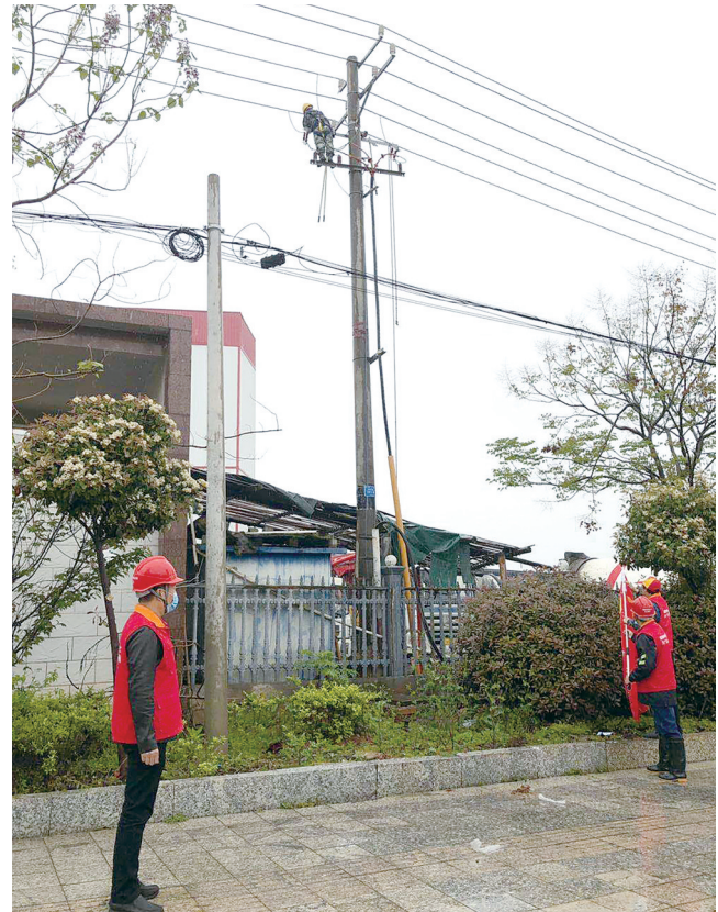
供电工人开展线路检修。陈翥 供图
