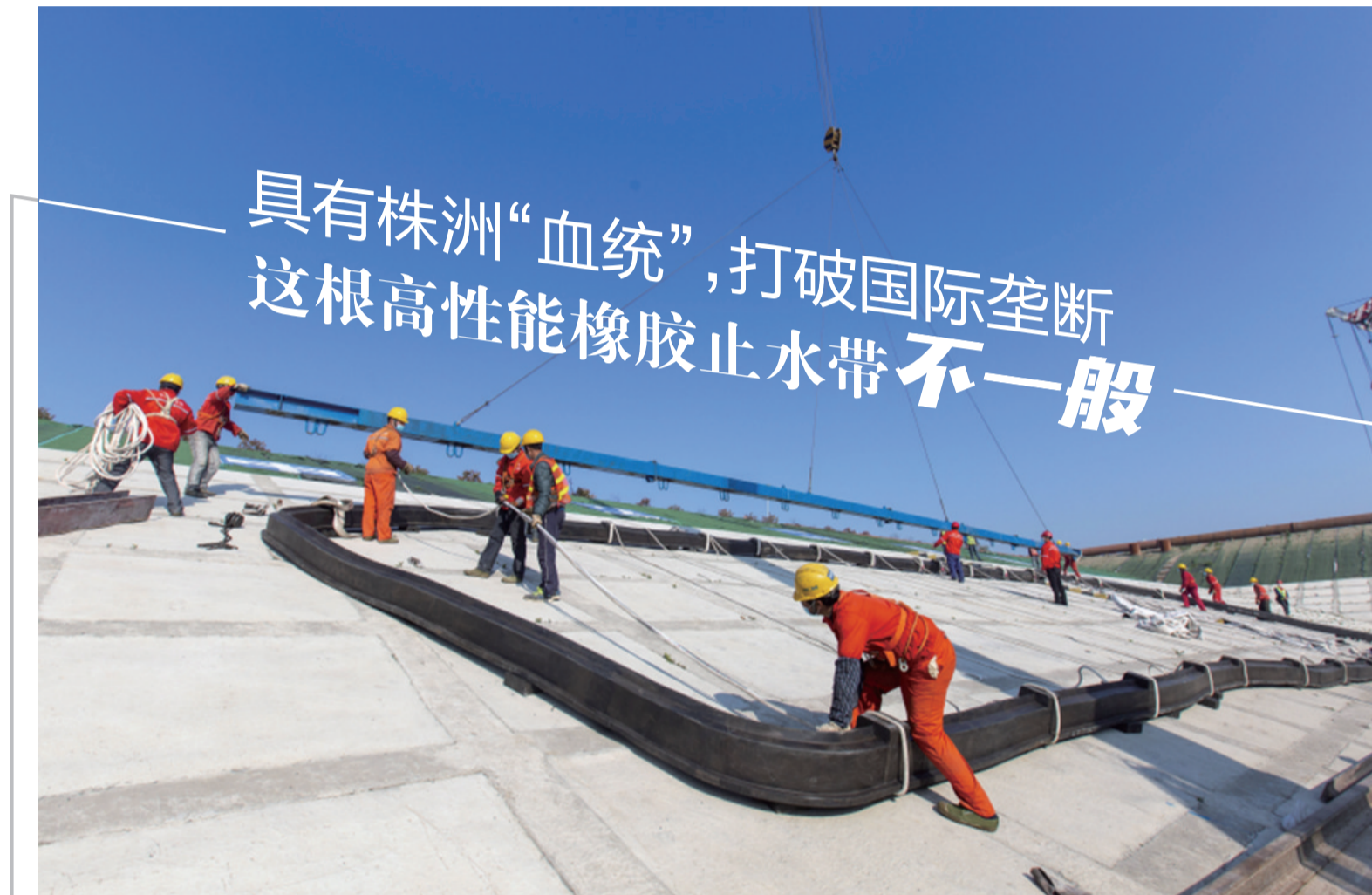
▲我国自主研发的高性能橡胶止水带首次在沉管隧道施工中使用 受访企业 供图
