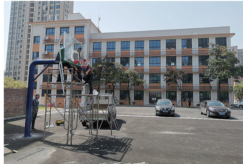
▲昨日,施工人员正在安装篮球架 记者 戴凜 摄
