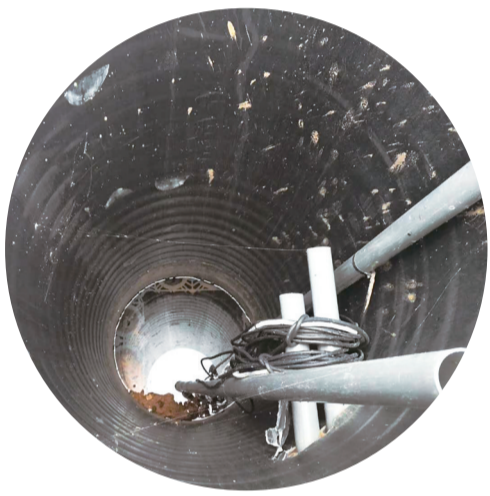
小区内的雨水收集系统 吴楚/提供
