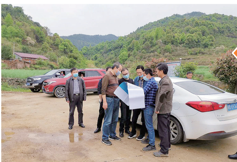
督查组查看地质灾害治理工程施工情况。通讯员 供图
