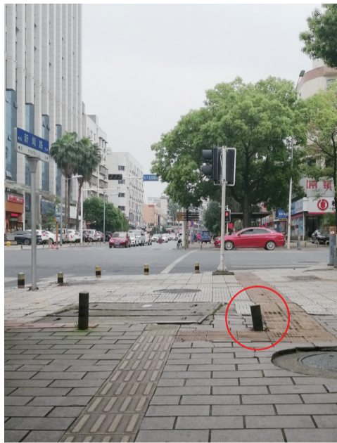
▲新闻路口有根隔离柱距盲道仅几厘米 记者 陈驰 摄
