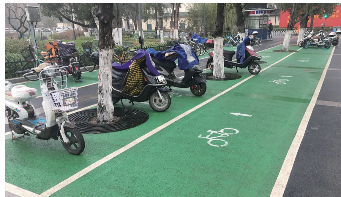
▲红旗广场沿线非机动车停车区域,提质改造造成一条“绿飘带” 记者 伍靖雯 摄
