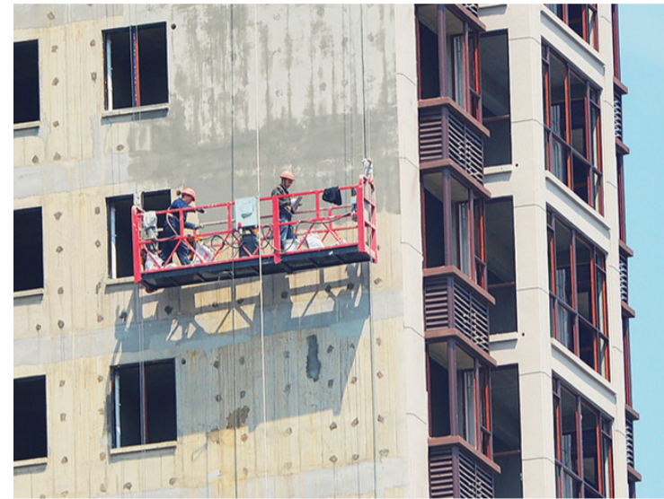
▲森林公馆现场,工人师傅正在高空作业 谢慧 摄
