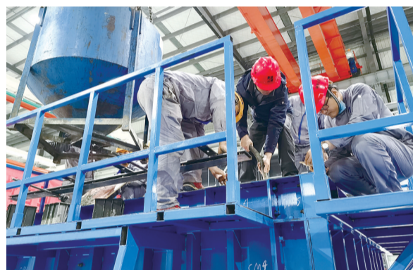
在工厂制作电梯井,工人们正在浇筑混凝土
