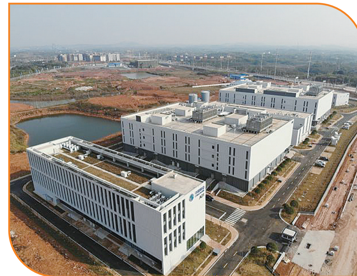
▲中国移动(湖南株洲)数据中心 通讯员 供图
