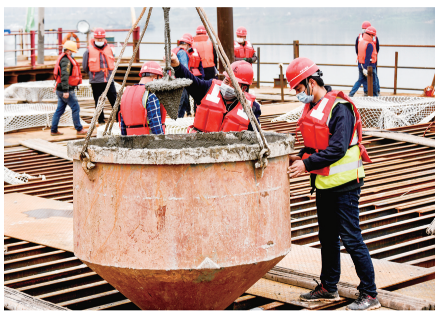
▲清水塘大桥施工现场,工人们精心浇筑。
