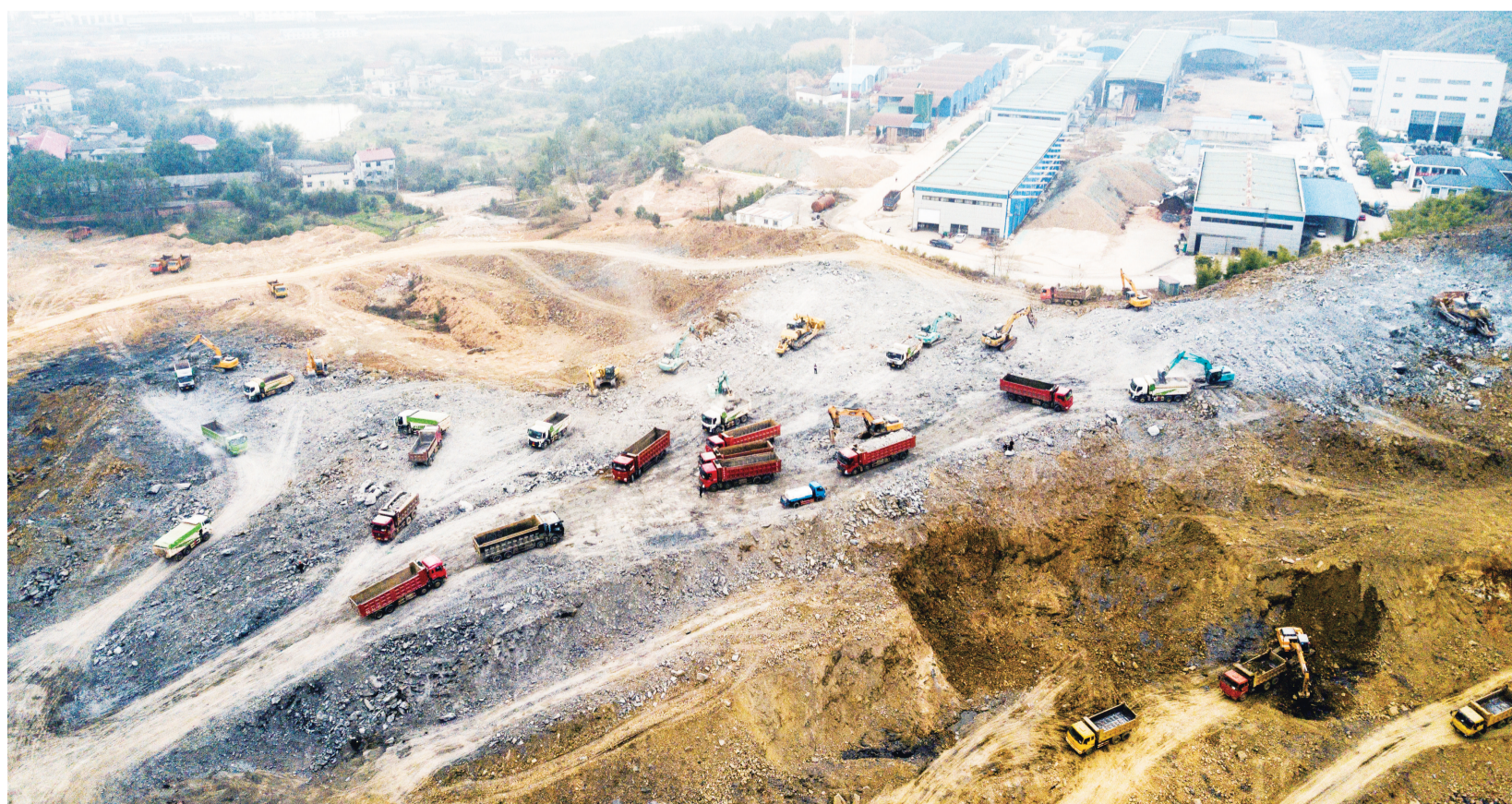
▲三一智慧钢铁城项目,施工车辆川流不息。
