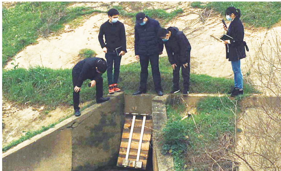
云龙区应急管理部门工作人员对双丰社区荷叶坝进行隐患排查。通讯员/汪程 摄
