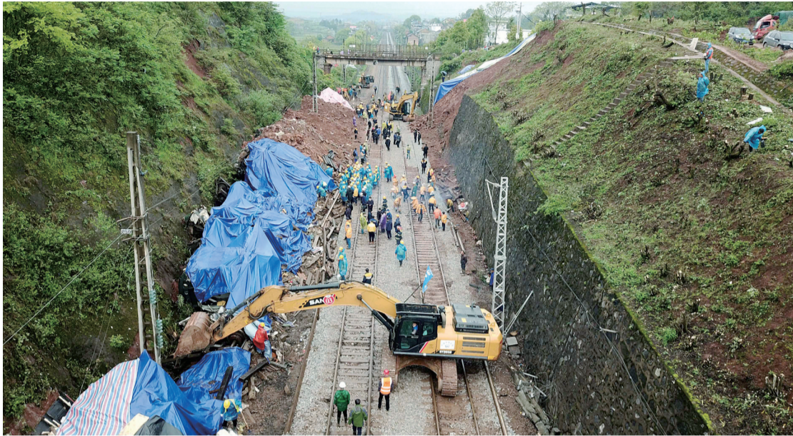
▲3月31日,工程车辆在T179次客运列车脱轨现场作业(无人机照片)
