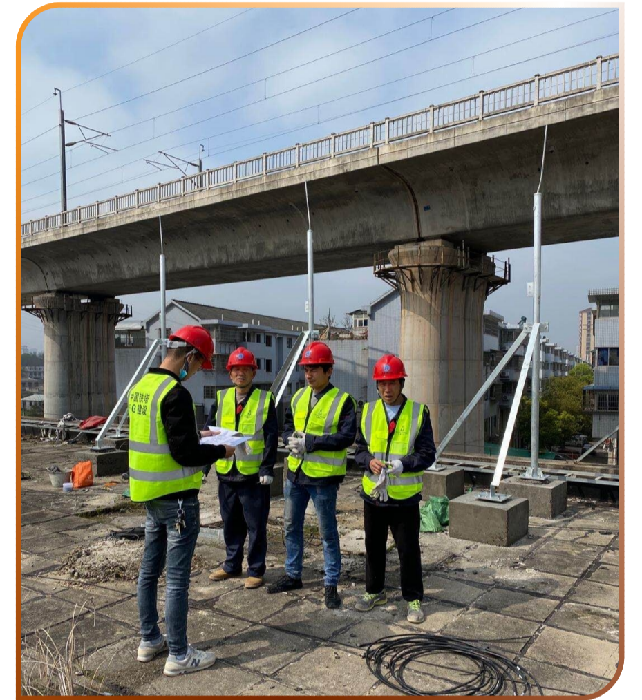
▲5G基站建设项目现场 通讯员供图
