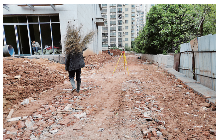
▲共和城小区旁边的建筑工地正在施工 记者 姚时美 摄
