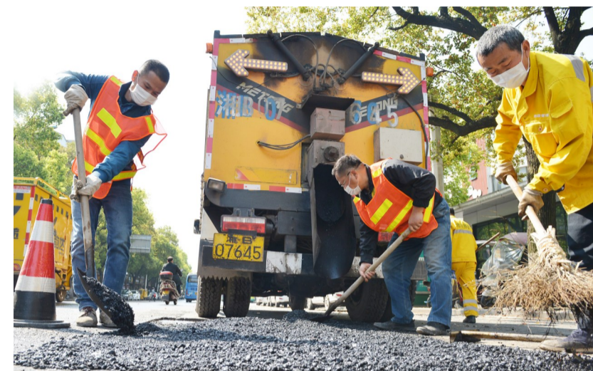
▲3月19日,清石广场,市政养护人员正在维修路面 记者 谢慧 摄
