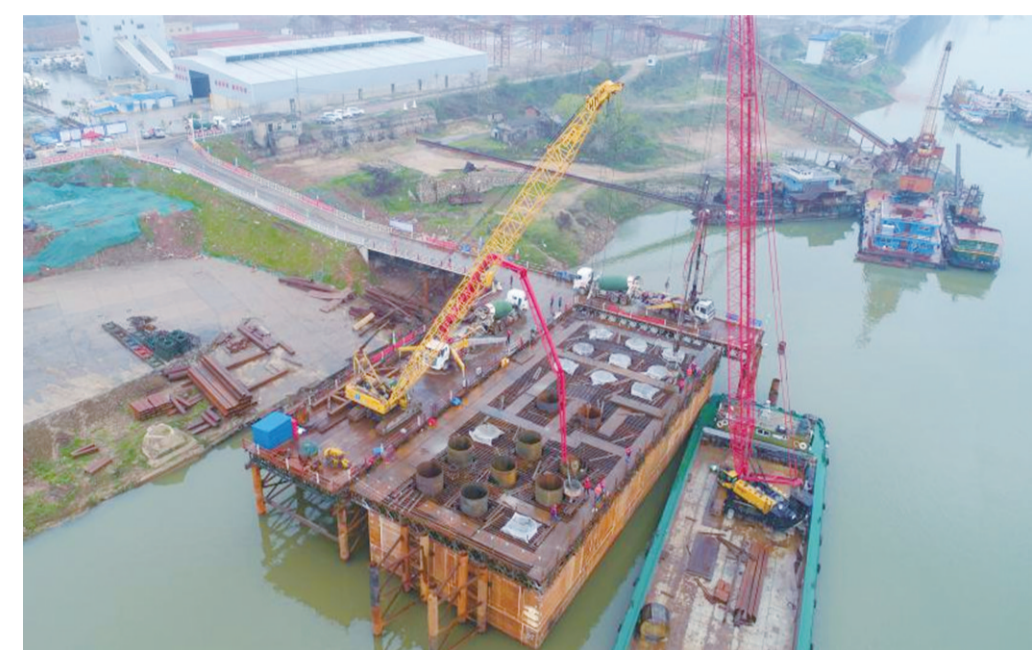
▲清水塘大桥施工现场图 通讯员供图
