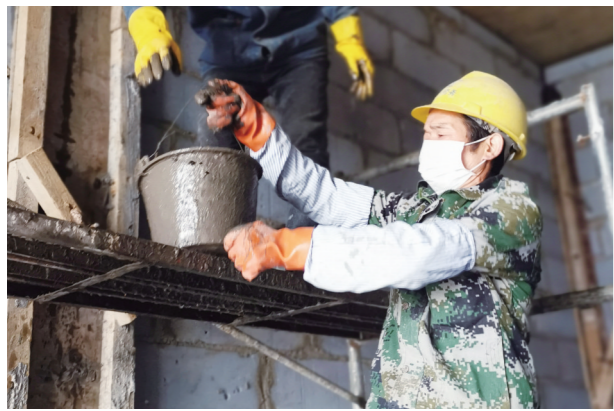
施工人员在浇筑混凝土。沈全华 摄
